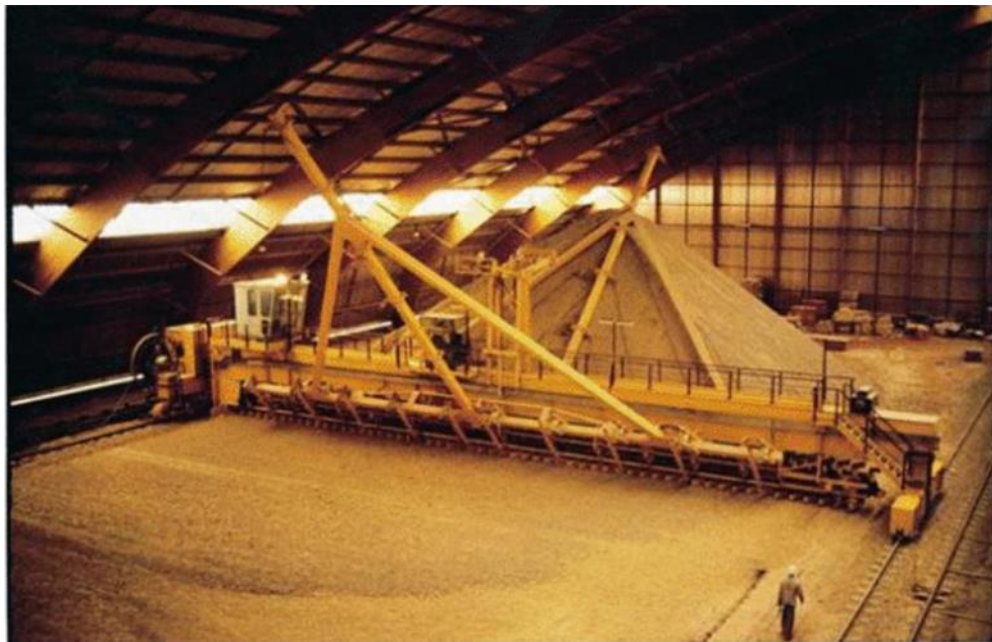
Рисунок 1.6 Закрытый склад с использованием штабелеукладчиков
