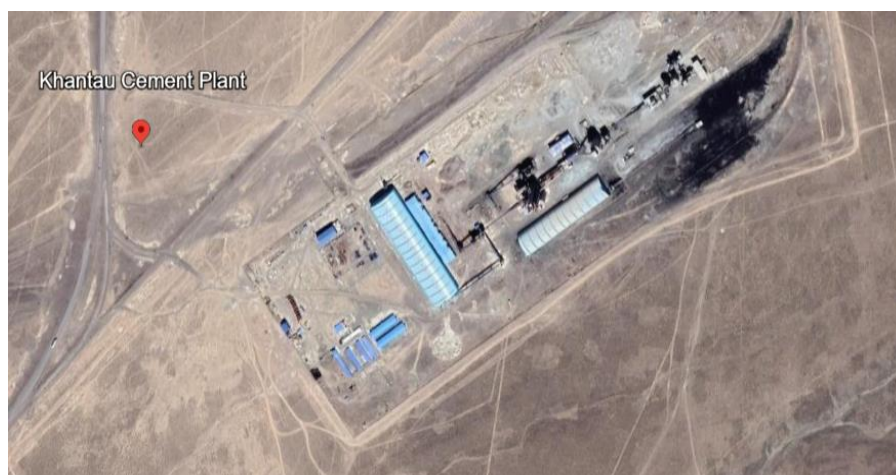
Рисунок 1.1 – Расположение Хантауского цементного завода
